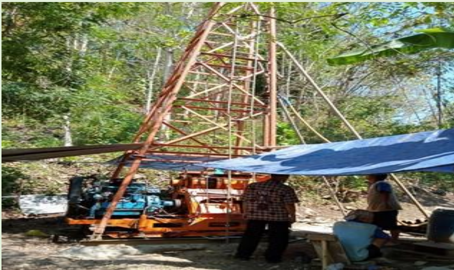
Gambar III. 27 Pembangunan irigasi air tanah dalam KBN (DAK)
